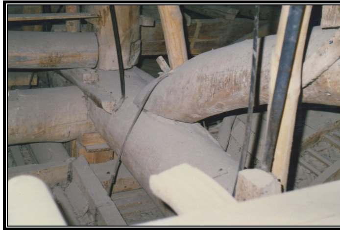
شکل ۳۶. تیرهای اصلی و فرعی چوبی در دو جهت: عضو مورب خرابایی روی تیر اصلی، تیرچه روی تیر فرعی، محل برخورد تیر اصلی و فرعی روی سر ستون و قاب‌سازی کف با اتصال توسط تسمه‌های آهنی در زیر مجموعه قرار دارد.
