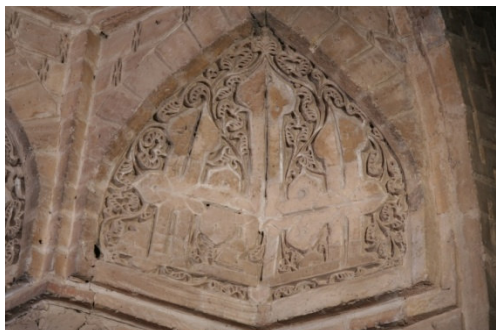
تصویر ۱۵. تصویر و اجرای کتیبه آجری «الملک‌الله» به خط کوفی ساده با تزئینات اسلیمی ساده گچ‌بری، محراب مسجد جامع برسیان، دوره سلجوقی
