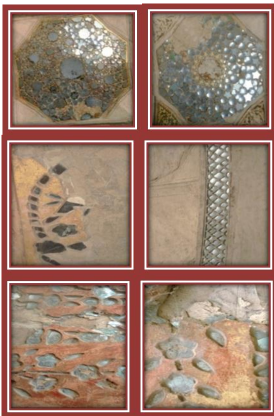
تصاویر ۲۸-۲۳. کپبری‌های سقف، کپبری ازاره و قوس طاق، کاخ هشت بهشت، اصفهان
