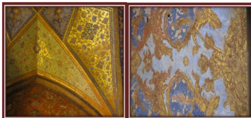
تصویر ۳۲ لایه چینی دیوار تالار مرکزی، چهلستون تصویر ۳۳ آسیب لایه چینی دیوار، چهلستون
