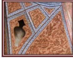
تصویر ۲۰. ریزش لایه چینی‌های دیوار طبقه ششم، کاخ عالی‌قاپو تصویر ۲۱. لایه چینی‌های سقف طبقه ششم، عالی‌قاپو
